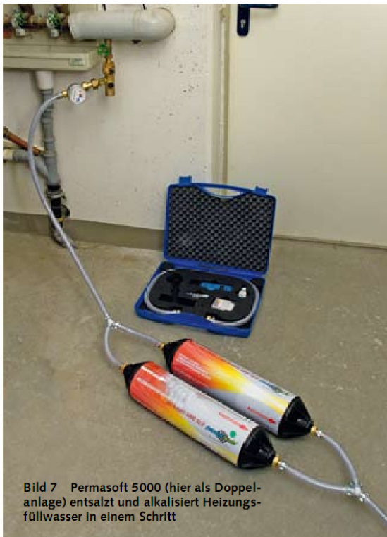
Obr. 7 Permasoft 5000 (tu ako dvojité zariadenie) odsoľuje a alkalizuje plniacu vykurovaciu vodu v jednom kroku
